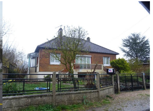
Maison de la Reconstruction
