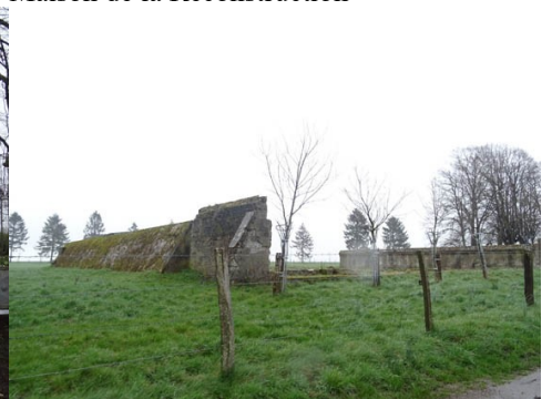
Structure en béton des hangars militaires
