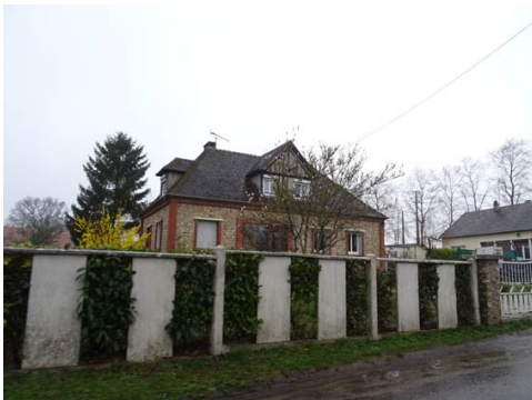
Maison de la Reconstruction
